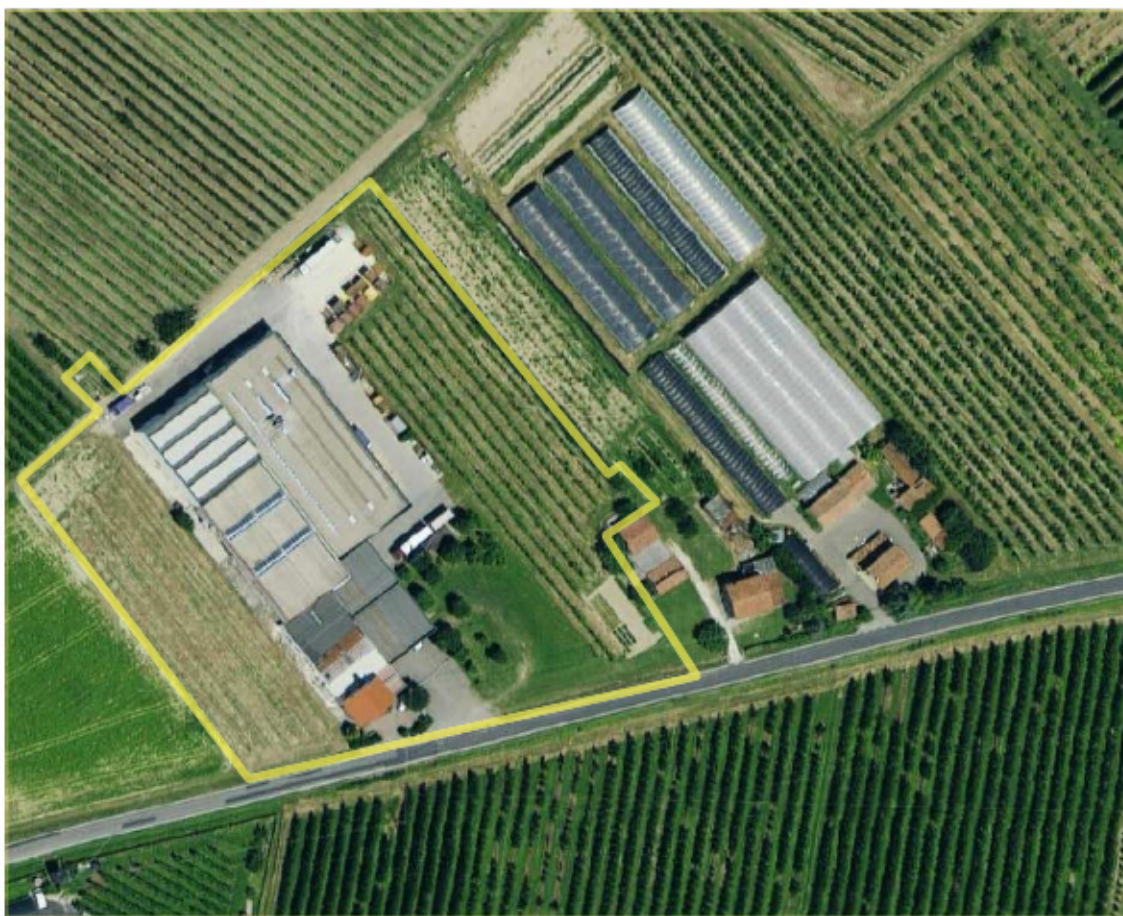
Vista aerea del complesso in relazione alla nuova superficie di progetto
