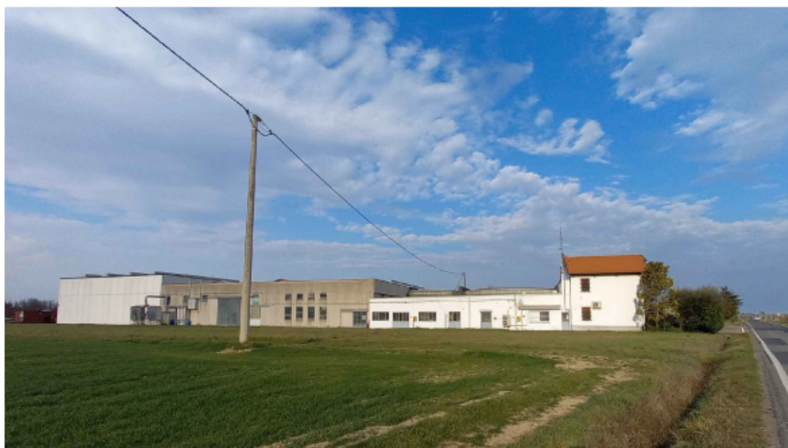
Vista del complesso da Via Reda (prospetto sud-ovest)
